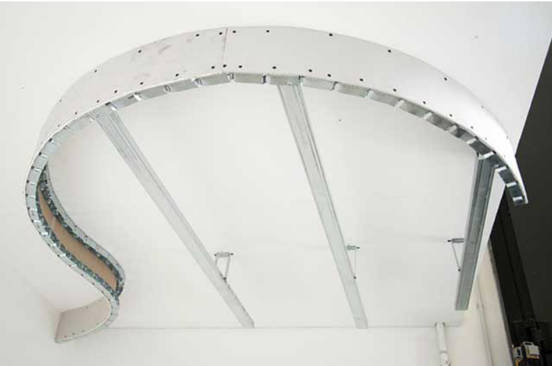
Rail courbe d'ossature métallique et du placo
